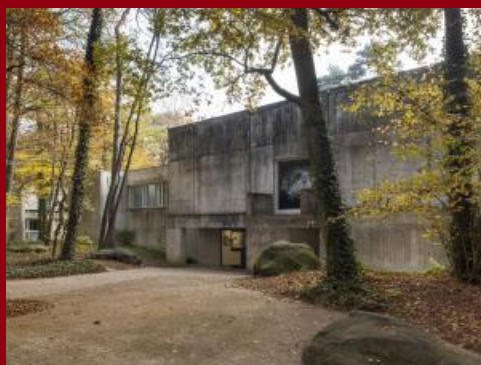
Vue de l'entrée du musée depuis le parc © Y. Bourhis/Département77
